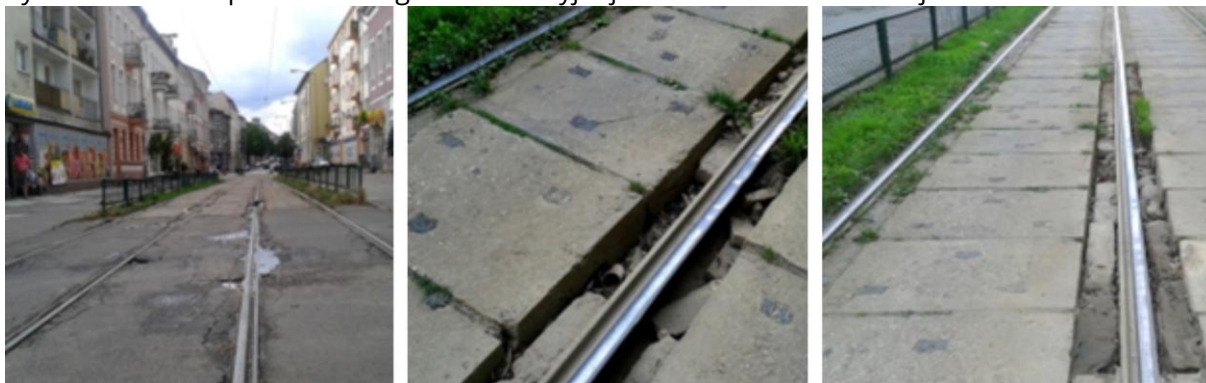
Rysunek 25. Niski poziom obsługi komunikacyjnej – infrastruktura tramwajowa
